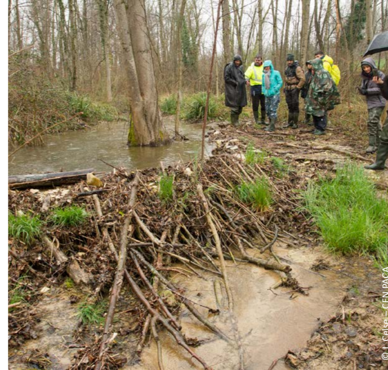
Echange technique autour de la mise en place d'un ouvrage mimétique Castor
