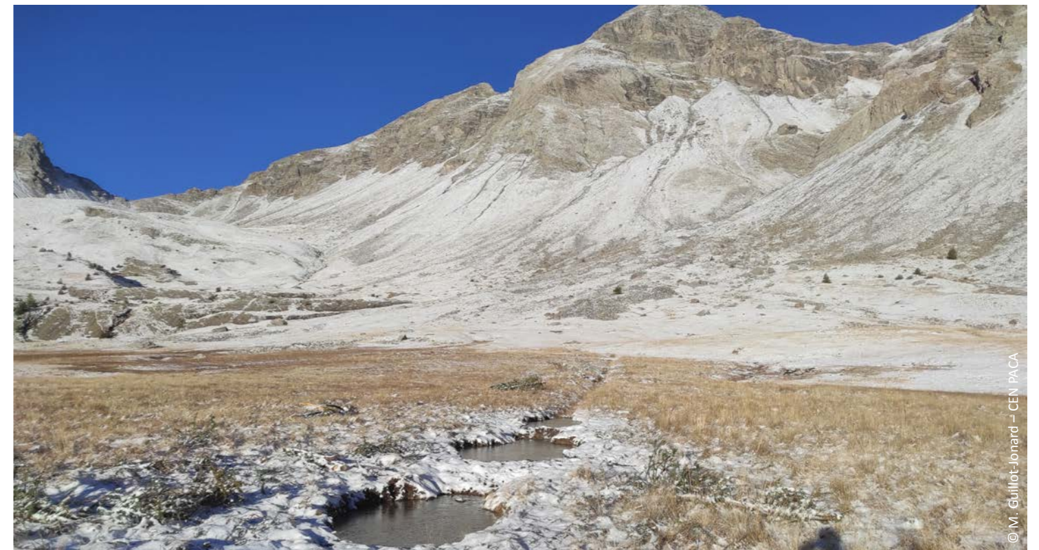
Ouvrages low-tech situés sur le drain principal de la zone humide à restaurer
