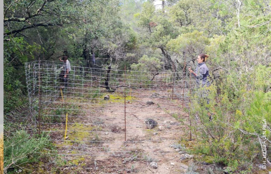
Installation de clôture de protection autour des transplantations d'Armérie de Belgentier
