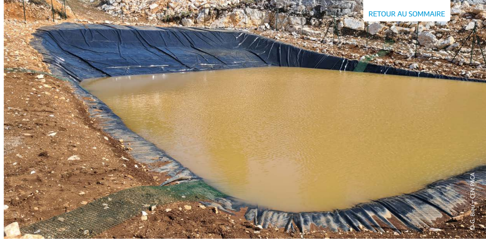
Impluvium avec rampes anti-noyade créé sur le site Natura 2000 « Montagne de Malay »
