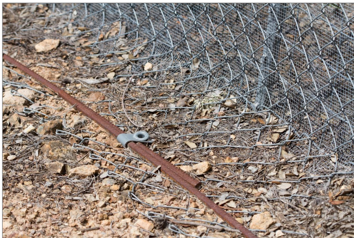
Pose de grillages en doublure, avec retour au sol et retour aérien du grillage fin © J. CELSE
