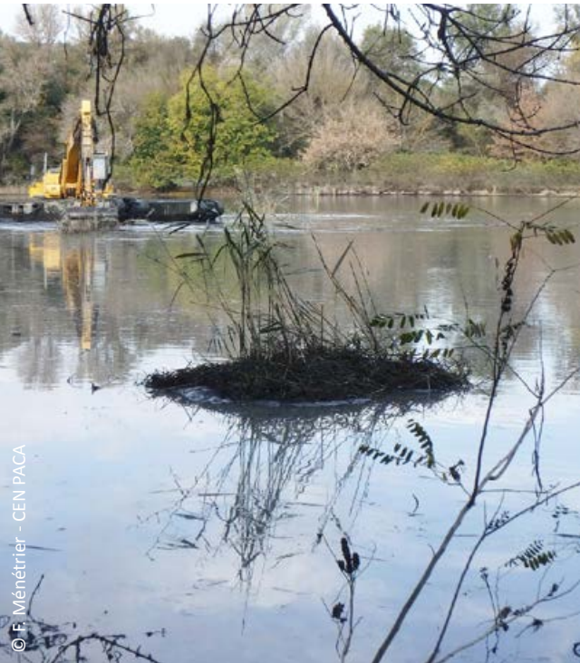
Travaux de restauration écologique de l'anse de l'Isdon de la Barthelasse (84)
