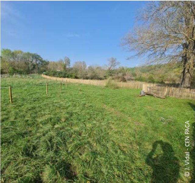
Aménagement de ganivelles sur le site de Fondurane (83)
