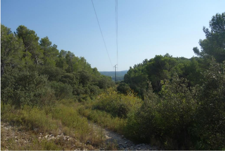
Photo 5 : Secteur et pylône ayant provoqué l'électrocution © C. Ponchon/CEN PACA
