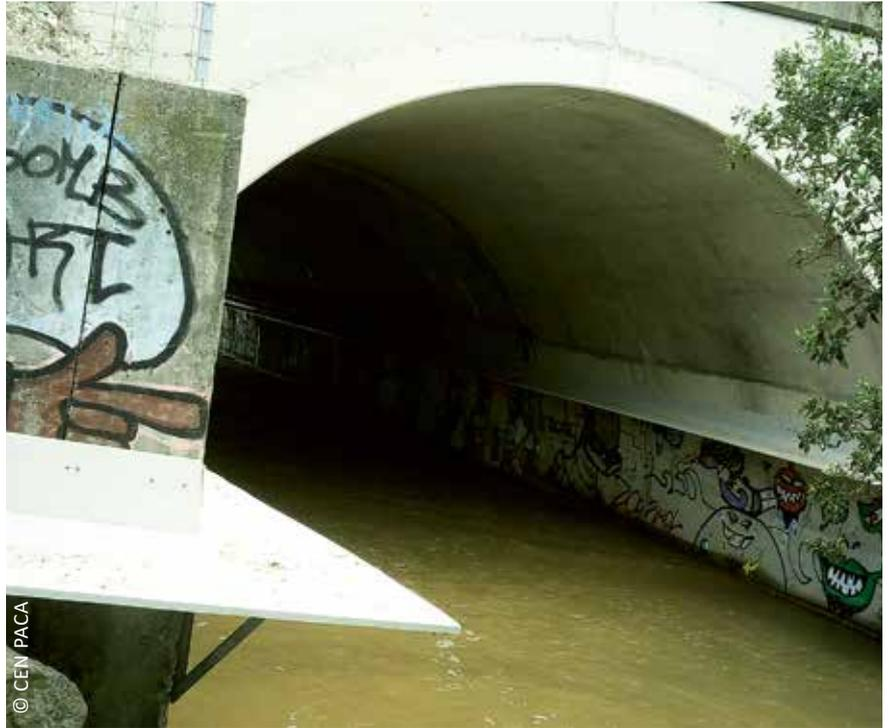
Exemple d'encorbellements sur un écoduc varois
