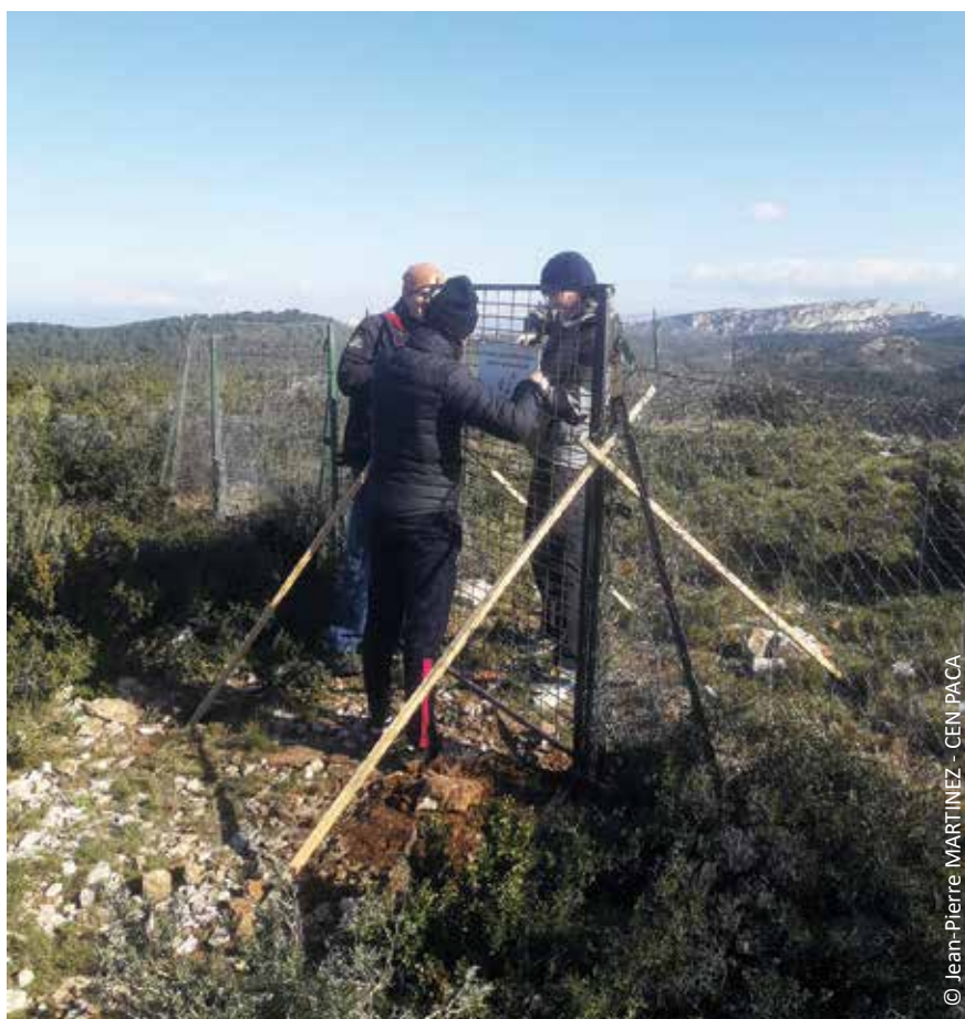
Deux TIGistes participant à la pose d'un portail sur l'une des placettes de nourrissage du Vautour percnoptère
