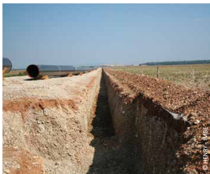
Régalaige de la terre végétale sur géotextile en prévision de la restauration du sol des coussouls après installation d'une canalisation enterrée
