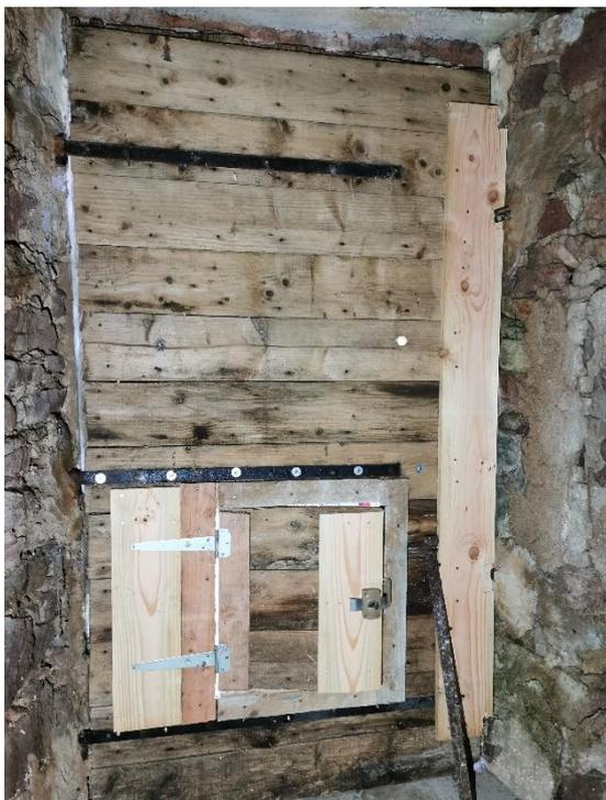
**PHOTO 3 : PORTE D'ENTREE RENFORCEE ET TRAPPE AMENAGEE - VUE DE L'INTERIEUR**
