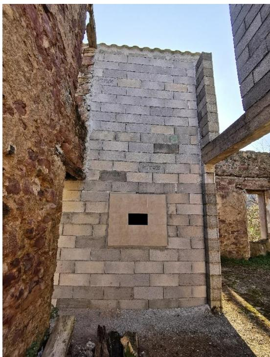
**PHOTO 5 : MUR DE LA CAGE D'ESCALIER RECONSTRUIT AU 1<sup>ER</sup> ETAGE DE LA BATISSE COTE NORD ET TROU D'ACCES POUR LES CHAUVES-SOURIS**
