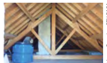
Pose d'une cloison pour éviter le dérangement des chauves-souris sur le site de La Roche, Le Lauzet-Ubaye (04)
