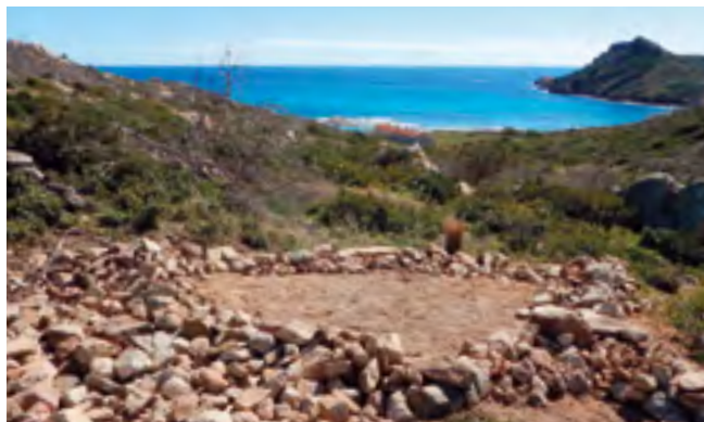
Démolition d'une dalle de béton au Cap Taillat, Ramatuelle (83)
