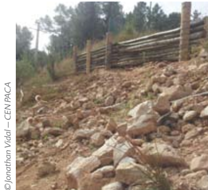
Réalisation d'une fascine pour lutter contre l'érosion du remblai
