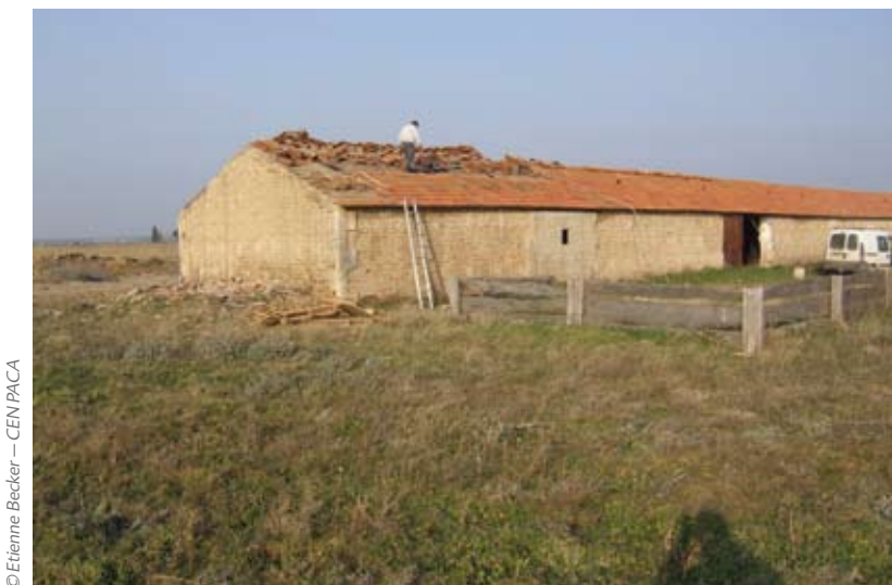
Rénovation de la toiture de la bergerie de Calissane (13)
