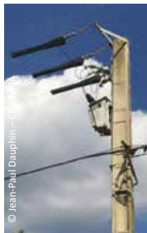
oiseaux, au posé et/ou au décollage touchant deux des fils sous tension s'électrocutent fatalement. Il suffit de poser des gouttières plastiques pour isoler les fils et le problème est résolu efficacement.
