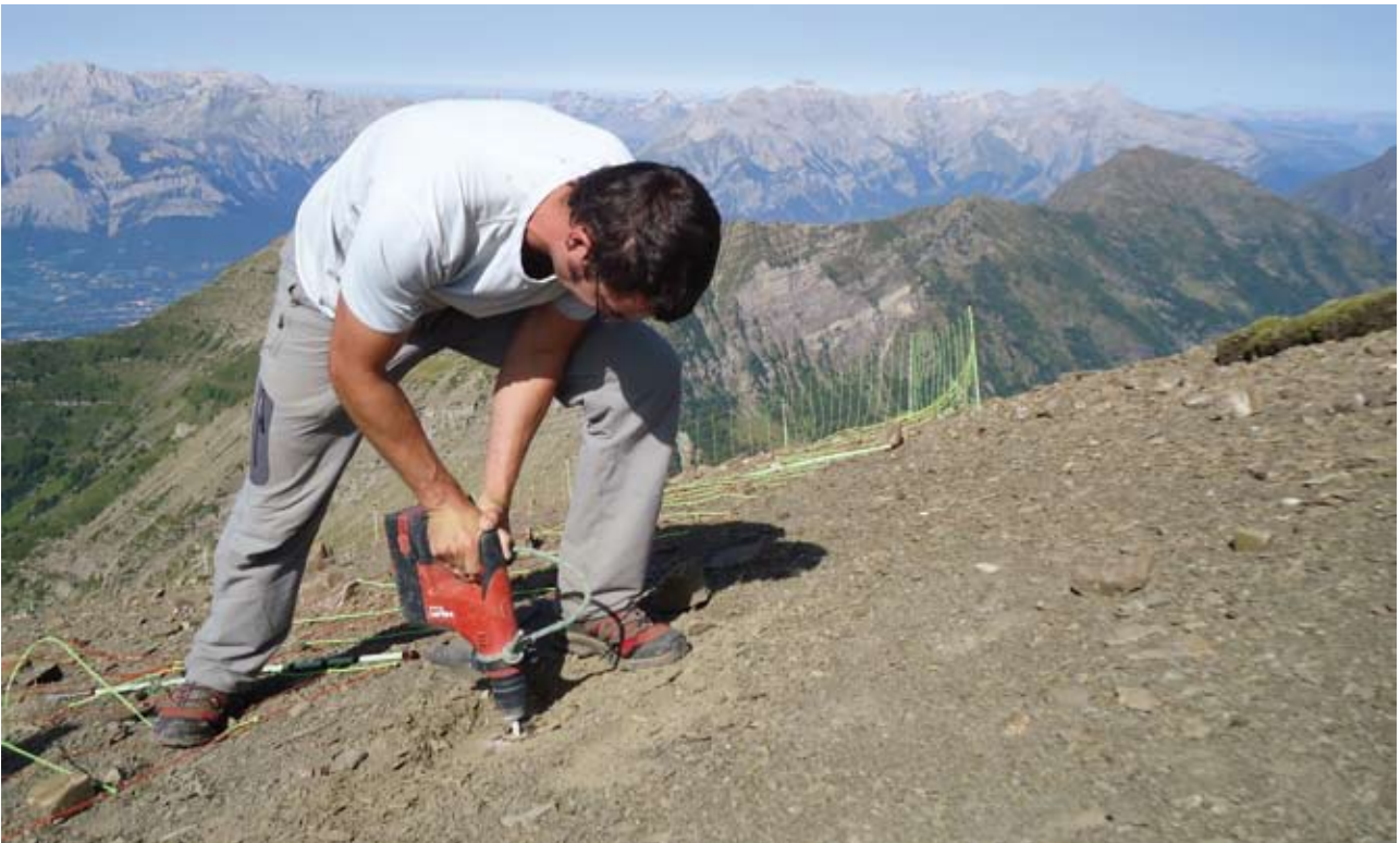
Figure 3 : Mise en place du défens (1) : perforation de la roche-mère pour fixation des filets de protection. Photo : Marc Corail/PNE Figure 3: Enclosure setting up (1): drilling of bedrock in order to set shepherd's nets. Picture: Marc Corail/PNE
