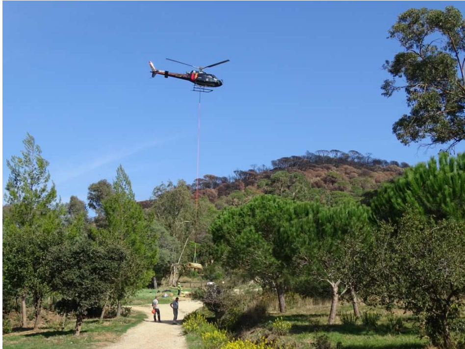
Héliportage des matériaux pour restaurer le sentier du Cap Taillat (4/10/2017)
