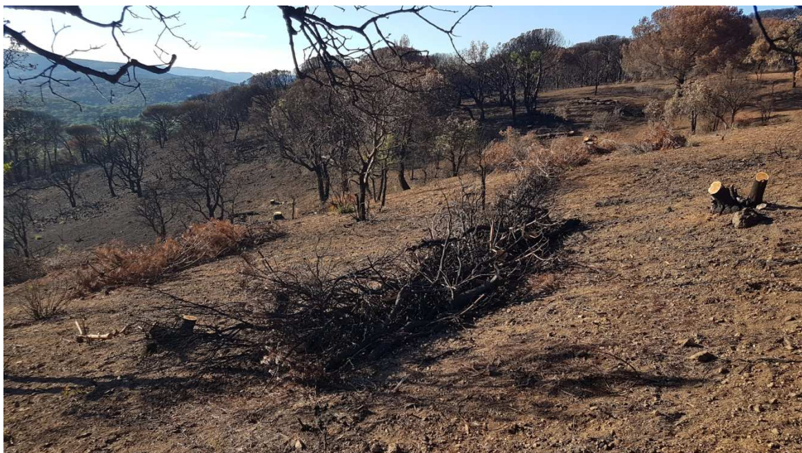
Mise en place de fascines pour retenir le sol et lutter contre l'érosion lors des premières pluies
